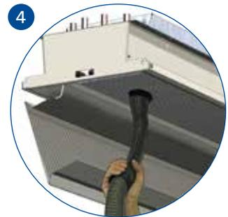
4 Nettoyez les surfaces à l'aide d'un aspirateur industriel équipé d'une brosse. Veillez à ne pas plier les ailettes en aluminium de la batterie.
