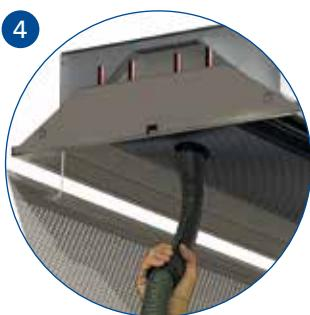
Drücken Sie den perforierten Teil des mittleren Segments, in der Mitte, neben einer der Abschlusskappen, um ca. 5 mm nach oben.
