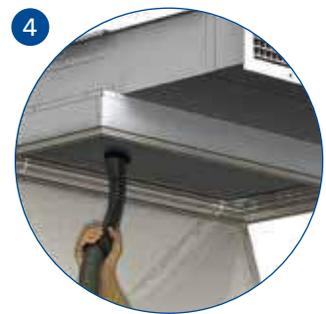
4 Reinigen Sie die Oberflächen mit einem Industriestaubsauger, der mit einer Haarbürste ausgestattet ist. Achten Sie darauf, dass sich die Alu-Rippen des Wärmetauschers nicht verbiegen.
