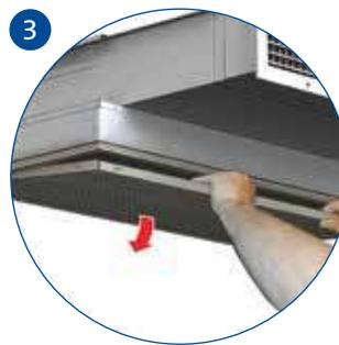
3 Das Gitter bleibt mittels 2 Sicherungskabeln mit der Einheit verbunden.
